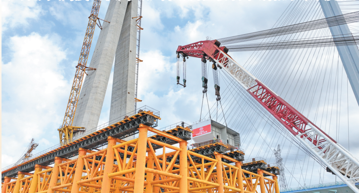
9月8日，随着钢梁顺利在滑移装置上就位，由中国铁建大桥局承建的甬舟铁路桃天门公铁两用大桥首节钢箱梁架设完成，标志着大桥建设正式进入钢梁架设关键阶段，为全线贯通奠定了坚实基础。图为钢箱梁架设现场。乔 虎 摄
