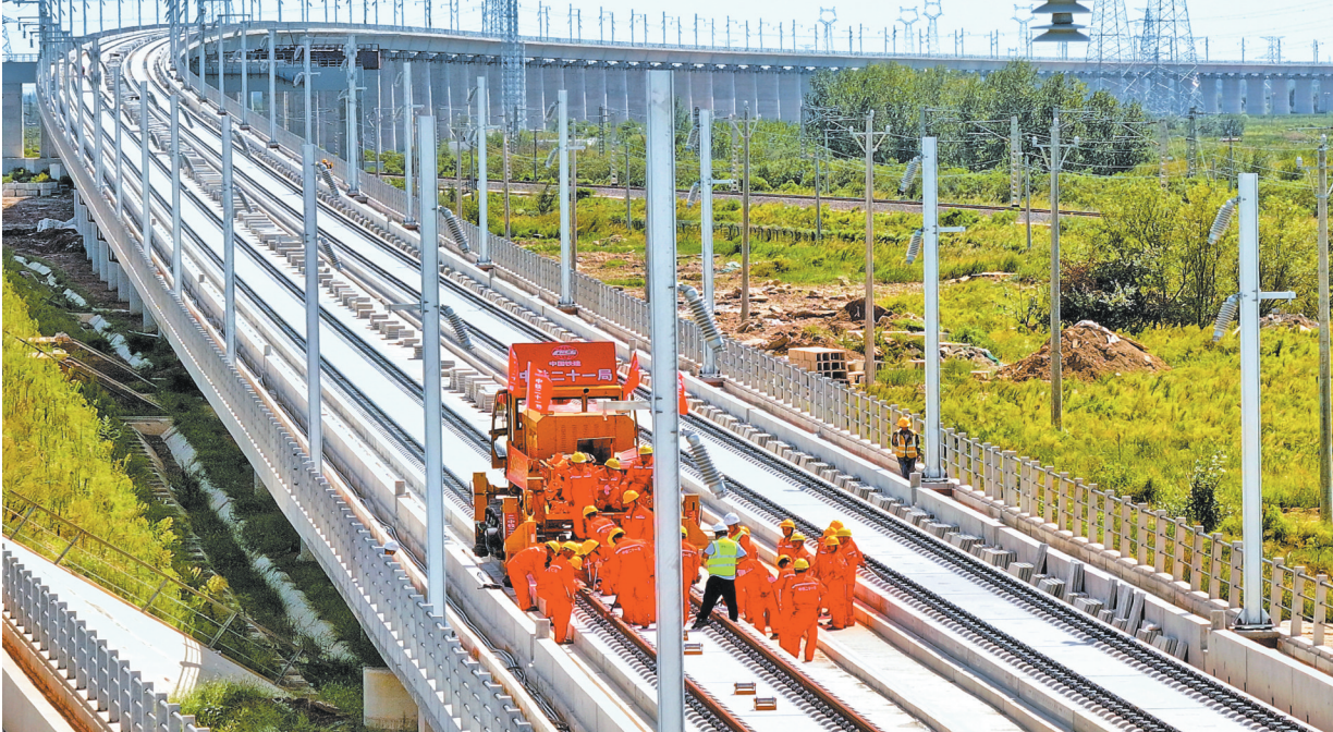
9月1日,随着东营南站首对500米长钢轨精准平稳落位在无砟道床上,标志着中铁二十一局参建的津潍高铁正式进入铺轨施工阶段,为全线早日贯通按下“加速键”。 石文静 摄
