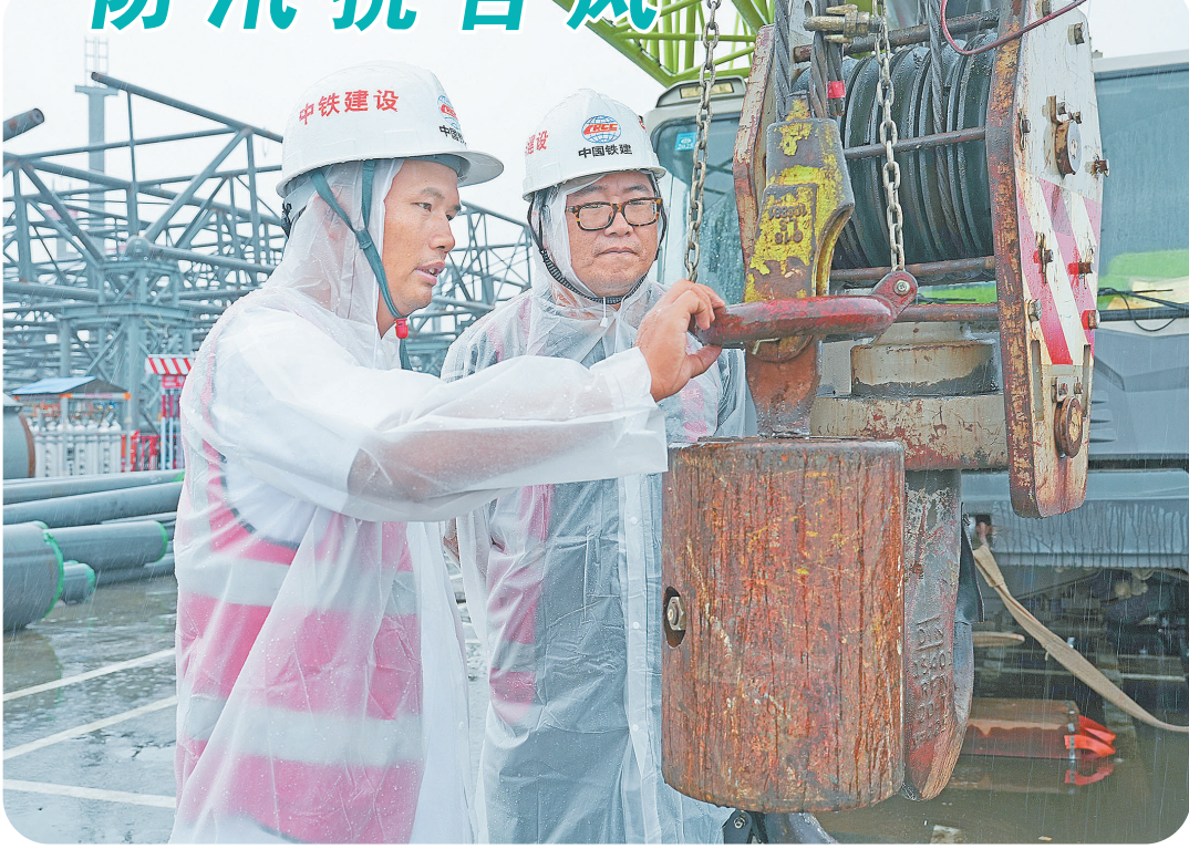
面对今年第十三号台风“白海豚”,中铁建设南京北站项目部青年突击队第一时间启动防台风应急响应,对施工现场排水系统、配电箱、大型机械设备等重点排查,同时专人24小时值班值守,实时跟踪台风动向,及时处置突发险情,全力保障项目人员生命安全和财产安全,筑牢防台风安全防线。图为青年突击队队员检查汽车吊防冲顶限位装置。 王鹏程 摄
