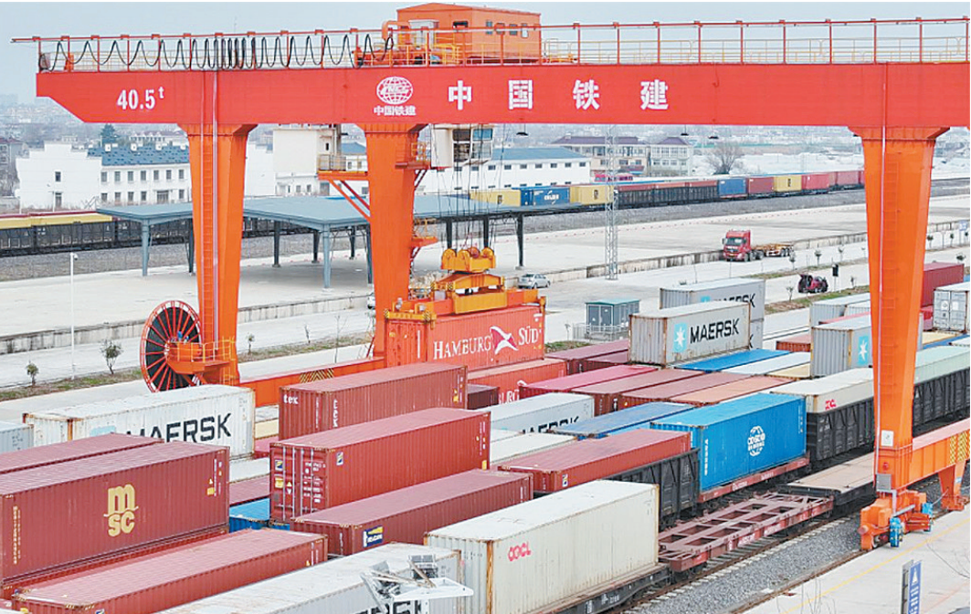
今年以来，中铁二十局投资运营管理分公司马鞍山浦南蒲港铁路项目部优化机车调度与装卸流程，完成运量29.2万吨，超额完成半年目标任务。目前，该项目开累完成运量突破180万吨大关，持续安全运营超过2000天。图为项目货场门式起重机进行各类国际集装箱集中中转装卸作业。 郭舒婷 摄
