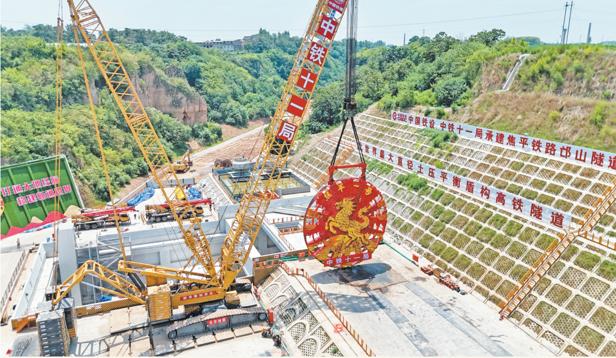
近日，在由中铁十一局承建的焦平铁路邙山隧道施工现场，国内最大直径土压平衡盾构机“焦平一号”刀盘顺利吊装下井，标志着世界最大直径土压平衡盾构高铁隧道进入始发掘进倒计时。图为“焦平一号”刀盘起吊。 吕龙程 摄
