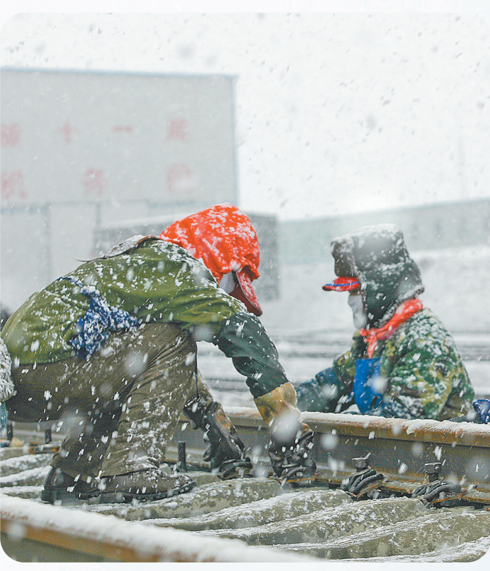
中铁十一局青藏铁路铺架项目部轨道队女工班。戴王杨 摄
