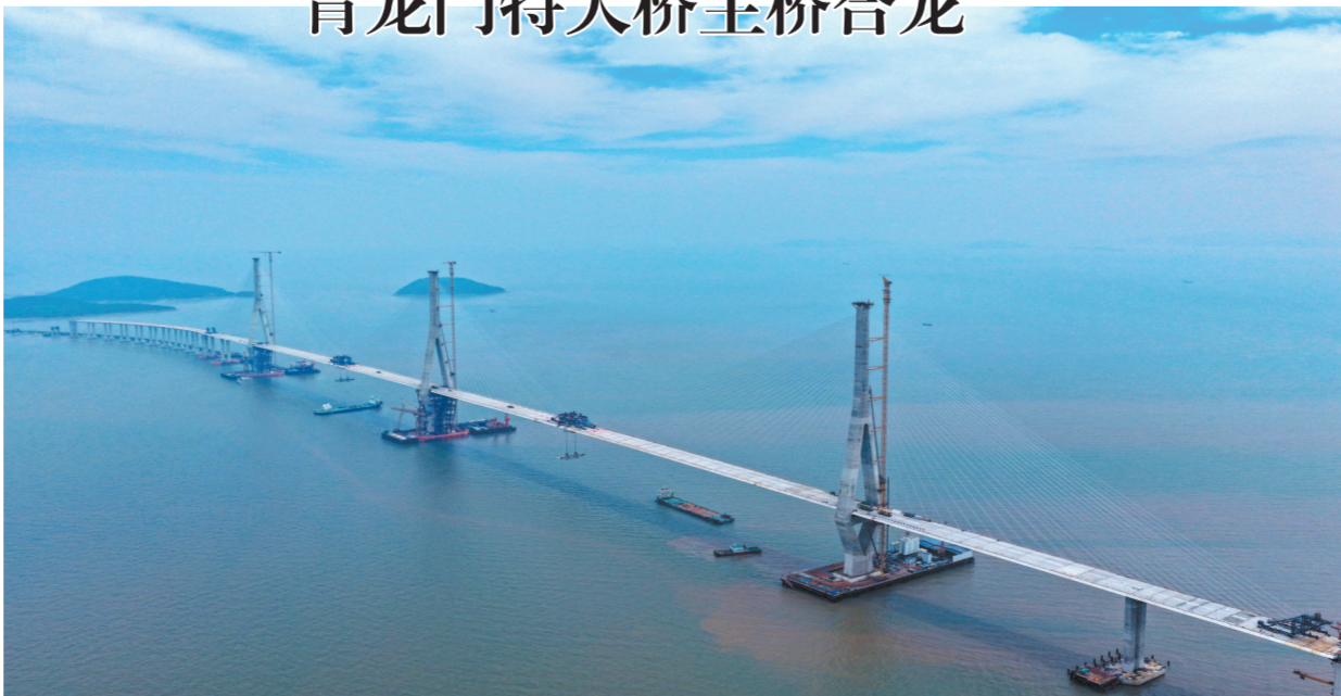
6月23日,随着最后两根钢梁同步提升到位,由中国铁建大桥局、中国铁建港航局联合承建的世界最大跨度三塔钢管箱梁斜拉桥——青龙门特大桥主桥顺利合龙。大桥全长2212米,双主跨各756米,三座主塔高249米。施工海域典型强潮强涌海域,全年6级以上大风天数过半,项目团队此次采用温度配切法实现毫米级精准合龙。
