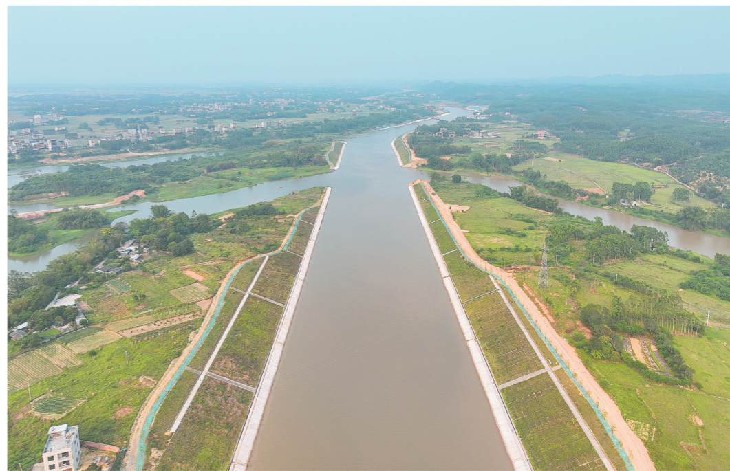
近日,新中国成立以来建设的第一条通江达海的运河工程、西部陆海新通道的骨干工程——平陆运河全线顺利通水,正式进入有水调试阶段。中国铁建港航局承建的航道10标,率先完成土石方开挖并以“零返工”高标准通过边坡验收,平整稳固的成型航道为运河按期通水提供了关键基础保障。目前该标段1.3公里航道已通过联合验收,项目团队正依托无人测量船、硬式扫床船开展清淤扫淤,全力冲刺9月通航目标。图为平陆运河航道10标成型岸线段。 郝奕凯 摄
