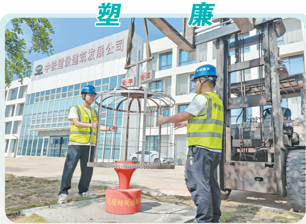
反腐倡廉宣传教育月期间,中铁建设建筑发展公司海南绿色建筑产业园利用废弃的钢筋、铁皮、混凝土等物料,由员工自主设计、制作“初心”“正道直行”“纪律利剑”等系列主题廉洁文化雕塑,以实景化载体推动全面从严治党向基层延伸。图为员工正在吊装“把权力关进制度的笼子”廉洁文化雕塑。
