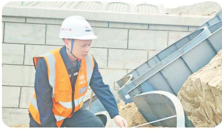
段利宾正在检查拱形骨架护坡间距。 于值雕 摄
