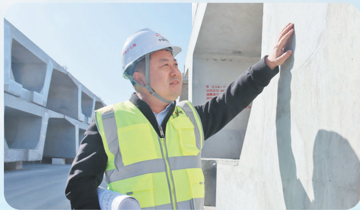
乔建永查看成品箱梁表面平整度。 段文婷 摄
