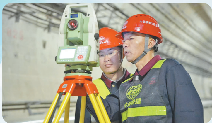
王永旭(右)在进行盾构区间导线测量。 王 颖 摄
