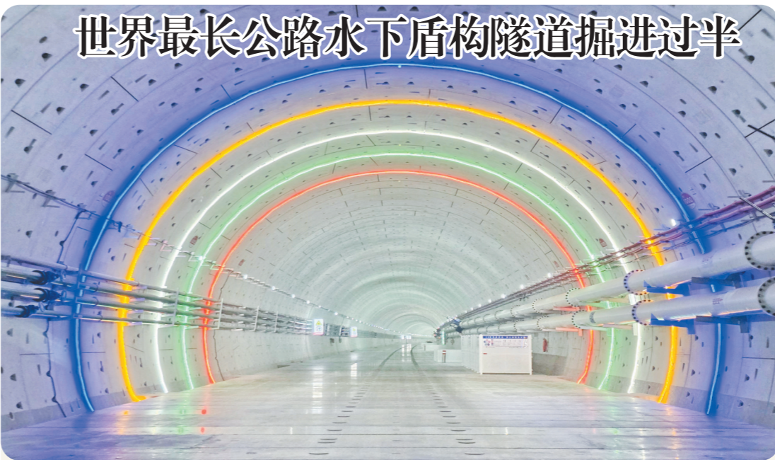
近日，由中铁十四局承建的海大长江隧道建设再传捷报，国产16米级超大直径盾构机“江海号”掘进突破4658米，实现总里程过半。该隧道是世界最长公路水下盾构隧道，中铁十四局负责的右线盾构段全长9315米。项目建成后，南通至苏州、上海的跨江通行时间将由1小时缩短至10分钟，大幅缩短长三角跨江出行时间，推动长三角核心区“1小时通勤圈”加速成型。图为修建成型的海大长江隧道。 田文祥 摄
