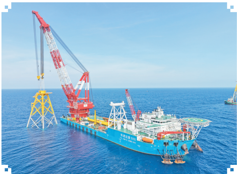
“铁建起重5000”进行导管架吊装。陈耀金 摄
