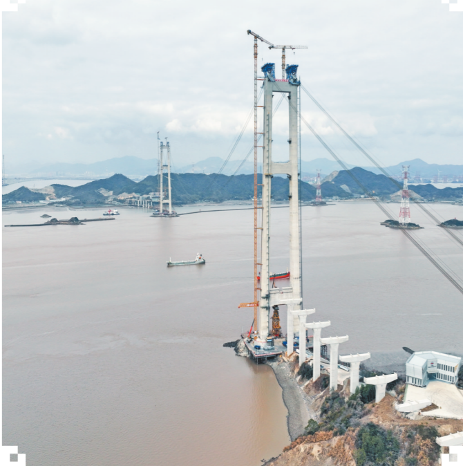
双屿门大桥全景 常宏摄
