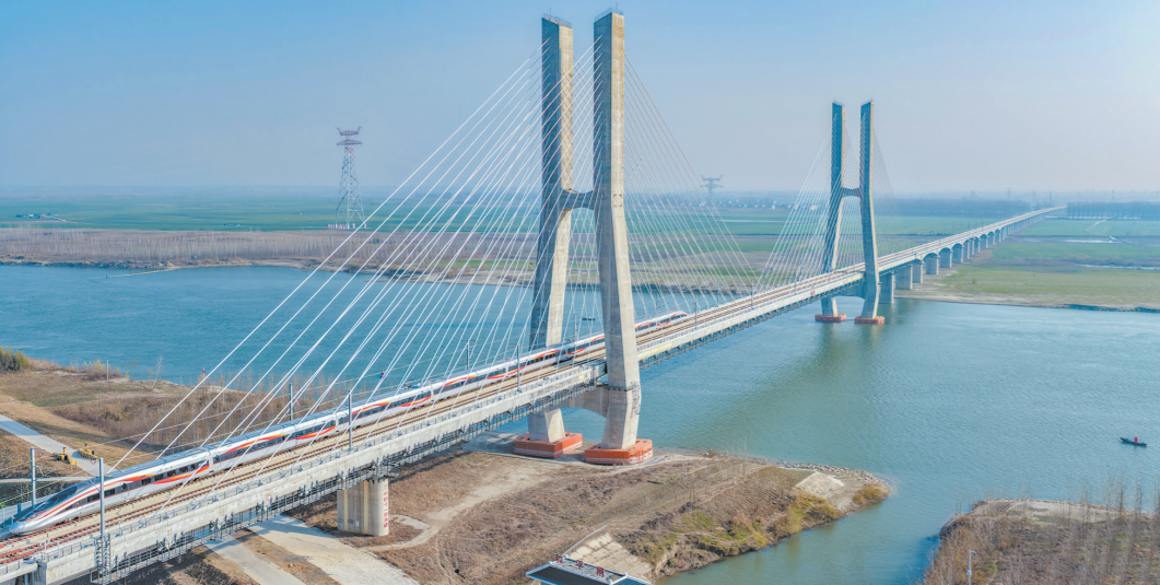
2025年12月26日,由中国铁建总体勘察设计和参与施工的沪渝蓉高铁武汉至宜昌段建成通车。该段正线全长314公里,设计时速350公里,全线新建桥梁88座、隧道25座,共设8座车站。通车后,武汉至宜昌间的旅行时间将从之前的约2小时缩短至1小时左右,钟祥、京山、当阳等多个城市正式迈入高铁时代,对服务长江经济带高质量发展、助力湖北建成中部崛起重要战略支点具有重要意义。图为首发列车通过钟祥汉江特大桥。 沈正华 摄
