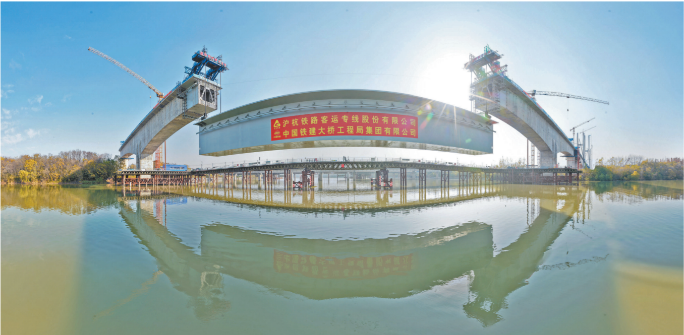
1月29日至30日,中国铁建大桥局参建的世界在建最长桥——梁沪渝蓉高铁通泰扬特大桥跨宁启铁路转体桥成功转体,跨凤河桥顺利合龙,两大重难点工程相继告捷,为全线贯通奠定了坚实基础。图为跨凤河桥合龙建设现场。杨宇摄
