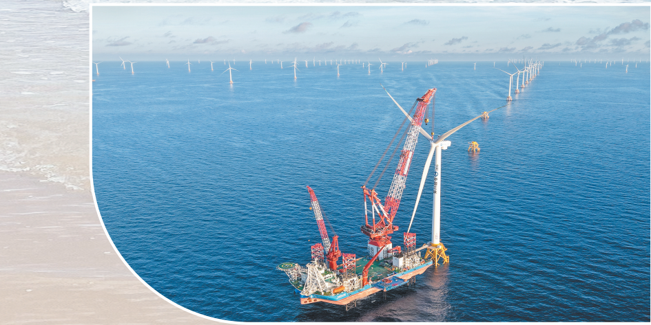
中国铁建港航局斥资打造的2000吨自升自航式风电安装船“铁建风电2000”。该船桩腿长131米,可在水深80米海域进行安装作业,最大起重能力达2000吨,可轻松胜任深远海、大兆瓦海上风电施工。图为“铁建风电2000”进行风机安装。 刘赞 摄
