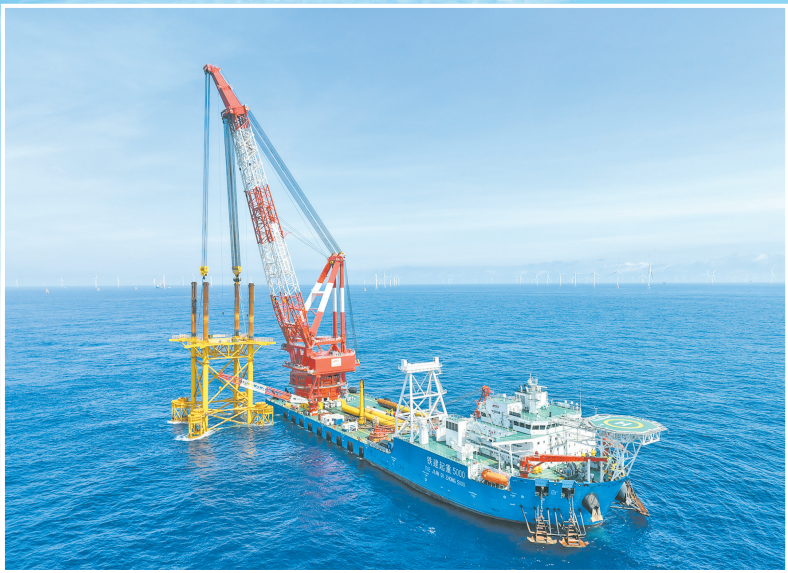
“铁建起重5000”是中国铁建港航局斥资打造的5000吨全回转起重船。该船搭载国内首制的闭环动力定位高压配电板和功率管理系统,拥有DP定位和八点锚泊定位系统,最大起重能力达5000吨,全回转起重能力达3500吨,是名副其实的“海上大力士”。图为“铁建起重5000”进行导向平台安装。 陈春鸿 摄
