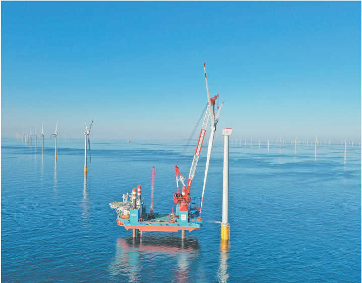
2021年12月16日,由中国铁建港航局承建的北方最大海上风电项目——华能大连庄河海上风电场址IV1项目顺利完工,实现同年开工同年全容量建成的建设目标。 于安 摄
