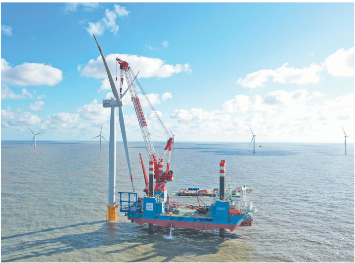
2021年10月30日,由中国铁建港航局承建的我国单体容量最大海上风电项目——启东H3号海上风电项目首个标段主体工程完工。该项目建成后上网电量可达22亿千瓦时。 于安 摄
