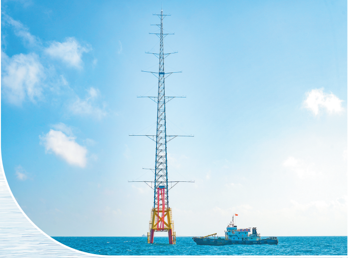
2019年11月17日,由中国铁建港航局承建的国内近海水深最深、施工难度最高的华电阳江青洲三海上风电测风塔顺利完工,创造了国内海上风电领域46米水深测风塔的最快安装纪录。 郭新璞 摄
