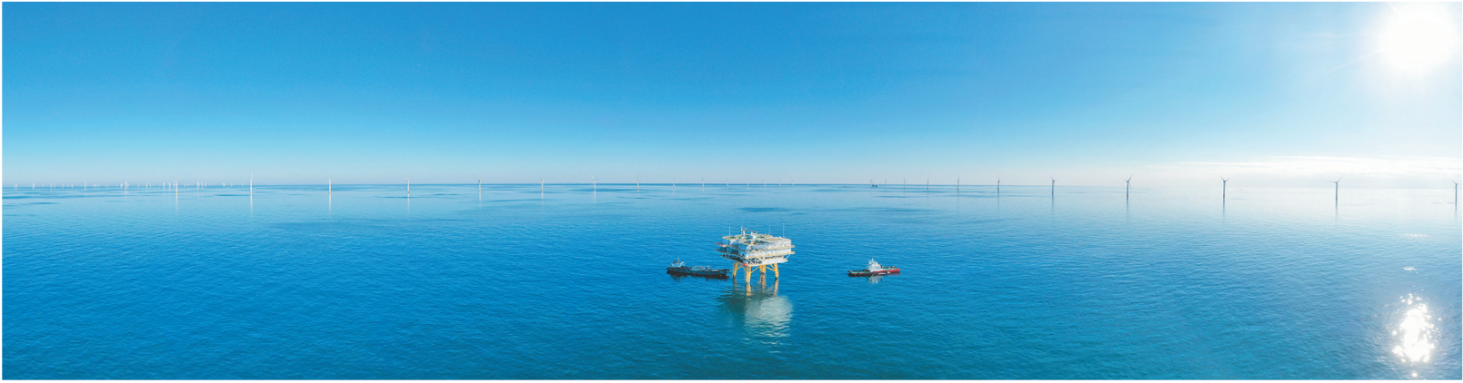
为积极践行国家“双碳”战略,中国铁建港航局全力进军海上风电行业,打造中国海上风电“蓝色引擎”。图为大连庄河海上风电风场全貌。 于安 摄
