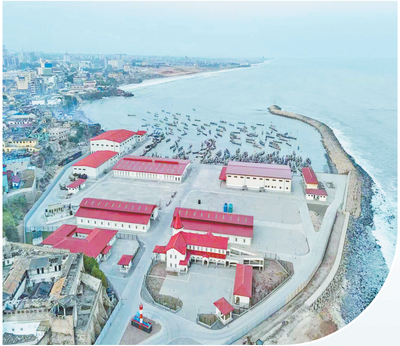
2024年9月13日,由中国铁建港航局承建的援加纳渔港综合设施项目顺利移交。该项目是中国铁建积极践行共建“一带一路”和中非合作论坛倡议的成果,是“真实亲诚”的又一具体实践,将助力中非携手推进现代化,共筑高水平中非命运共同体。 韩阳 摄
