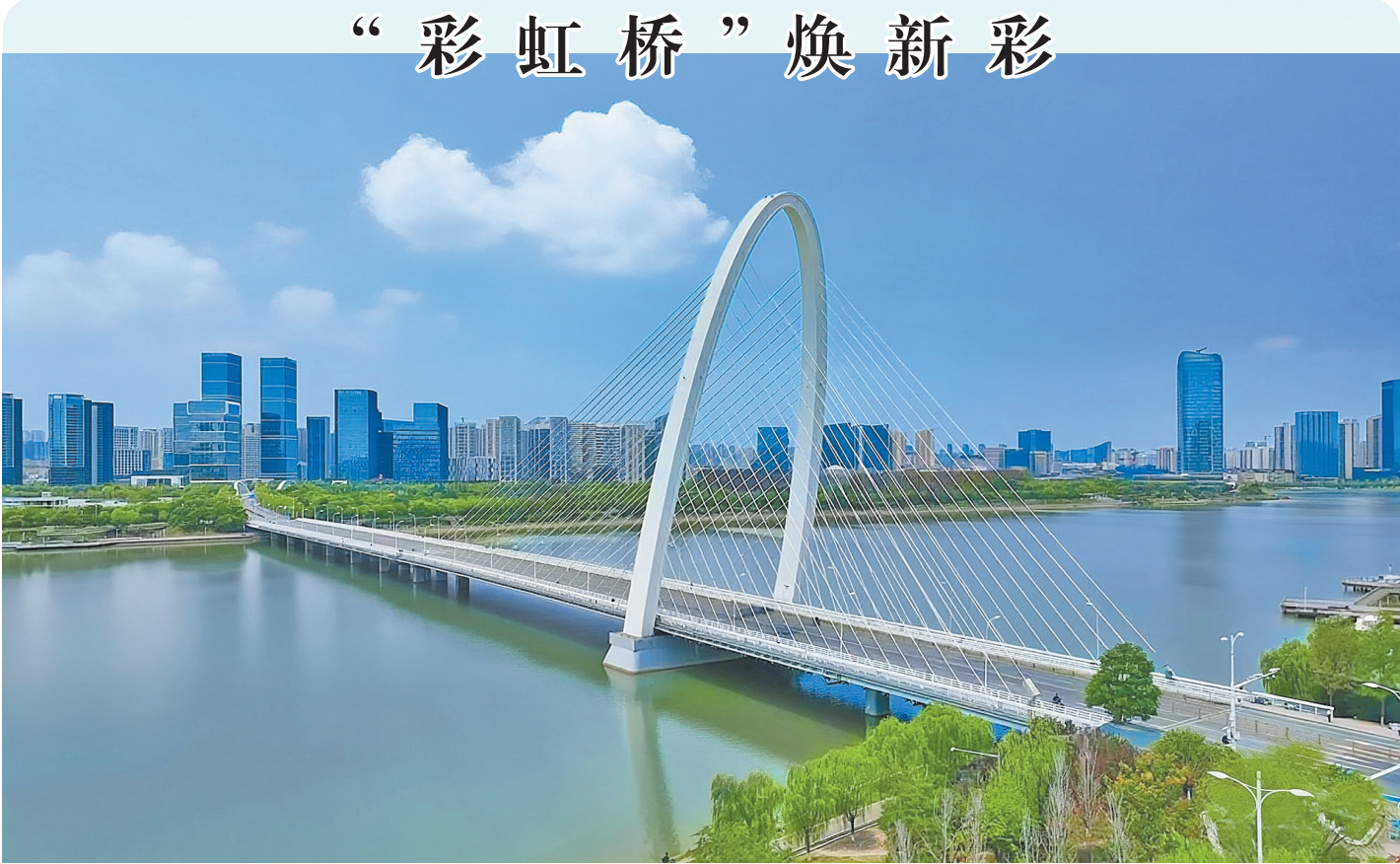
8月23日，经过74天的封闭施工，横跨陕西西安灞河的标志性建筑——灞河2号桥“彩虹桥”更新工程正式完工。这座高78米、主塔采用椭圆拱形塔，曾创下国内混合斜拉桥纪录的桥梁，由中铁二十局二公司、中铁长安重工公司成功完成全部斜拉索的更换，并同步植入智能监测系统，目前正以崭新面貌成为交通要道。
