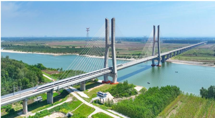
图为试验列车通过中铁十一局承建的世界最大主跨高速铁路无砟轨道混凝土梁斜拉桥——钟祥汉江特大桥。史少龙 摄
