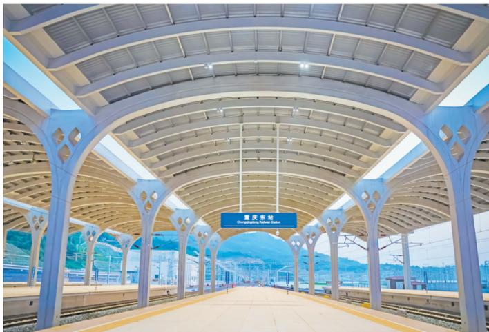
重庆东站基于BIM模型和三维激光点云技术,优化雨棚柱头结构,减少雨棚饰面装饰工序,打造国内首例多连拱钢混组合装配式雨棚。图为多连拱钢混组合装配式雨棚。
