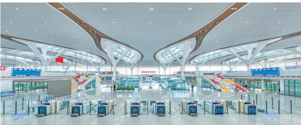
创新“现场数控出板+模块化吊装”工艺及微孔冲压成型技术,打造超13万米“管帘”状双曲天花吊顶,流畅线条模拟两江交汇的视觉效果,打造“站即景、城如画”的城市会客厅。图为候车大厅“管帘”天花吊顶。
