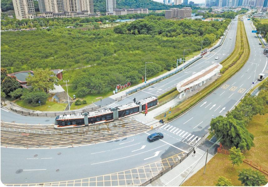
6月20日,由中铁二十五局承建的广东省重点工程——广州黄埔区有轨电车2号线北段开通初期运营。此次开通的北段全长4.9公里,设站8座,配车5列,线路采用嵌入式轨道,利用“超级电容+蓄电池储能电源”提供车辆行驶所需能耗,能够实现区间无接触网运行,在进站上下客时间,实现快充快放。全线建成通车后,将形成“地铁+有轨电车+公交”的全方位立体交通出行模式,为周边20余万市民出行提供便利。图为有轨电车行驶在轨道上。
