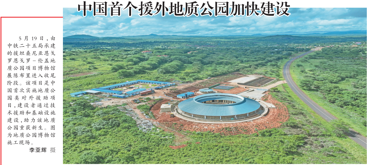
5月19日，由中铁二十五局承建的援坦桑尼亚恩戈罗恩戈罗—伦盖地地质公园项目博物馆展陈布置进入收尾阶段。该项目是中国首次实施地质公园类对外援助项目，建设者通过技术援助和基础设施建设，助力该地质公园重获新生。图为地质公园博物馆施工现场。
