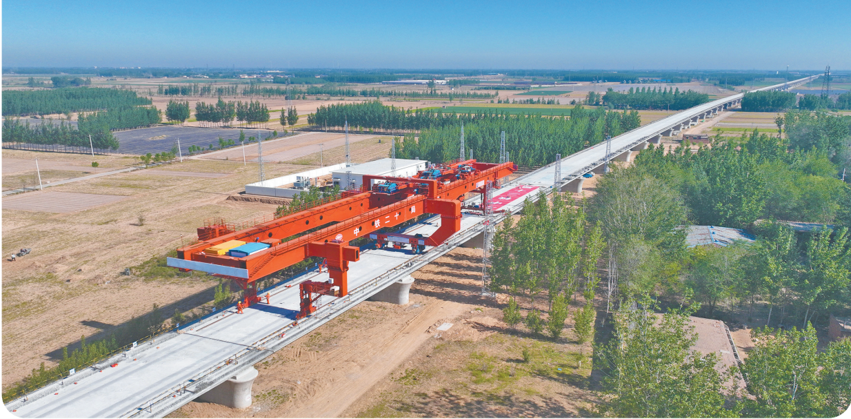
4月27日,由中铁二十局承建的雄(安)商(丘)高铁枣特大桥完成箱梁架设,雄商高铁河北段架梁施工全部完成,为后续无砟轨道施工创造了有利条件。图为雄商高铁河北段架梁施工完成。 韩展展 摄
