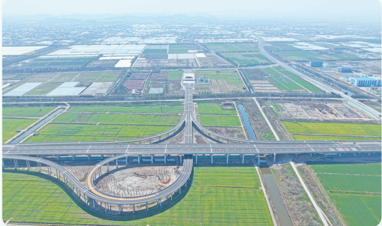
4月11日,中铁十六局参建的杭甬高速复线宁波段二期工程正式通车,标志着杭甬高速复线宁波段与杭绍甬高速杭绍段实现全线通车,长三角“湾区经济”迈入陆海联动新阶段。图为杭甬高速复线宁波段二期工程临山互通区。 王可娣 摄
