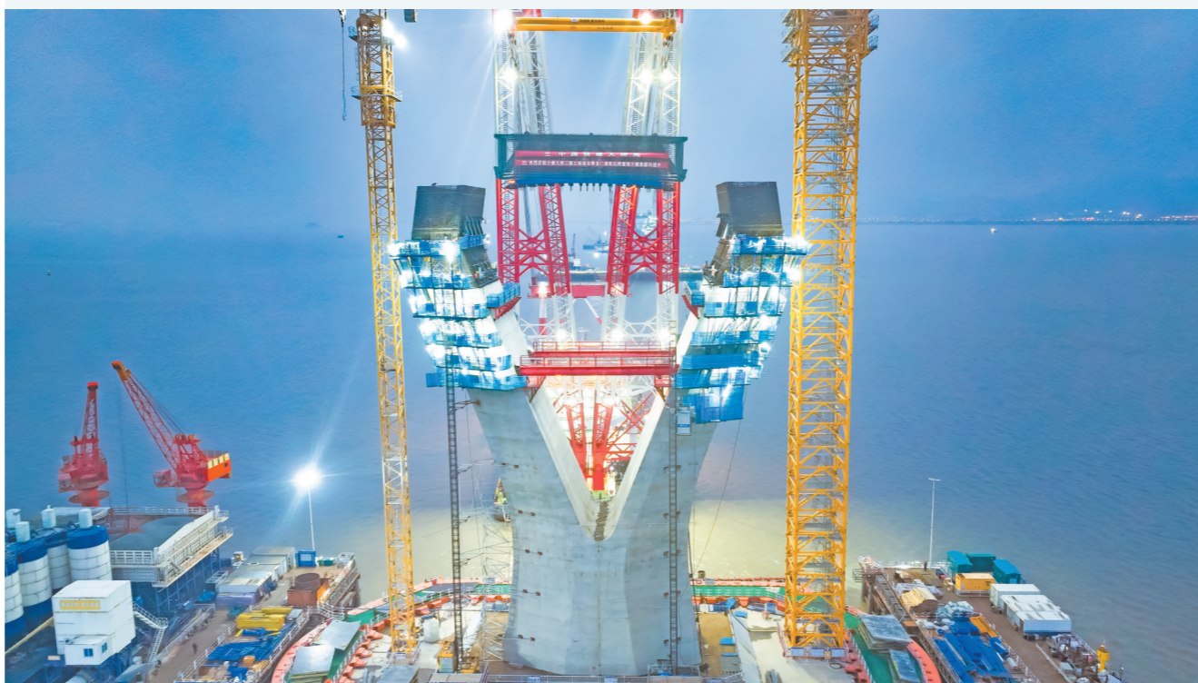
2月23日,随着“铁建大桥1号”2500吨起重船吊臂缓缓下放,由中国铁建大桥局参与建设的宁波舟山港六横公路大桥二期工程青龙门大桥3号主塔下横梁型钢骨架部品吊装完成,百米塔肢成功“牵手”,大桥主体结构施工进入新阶段。 孙镇霖 摄
