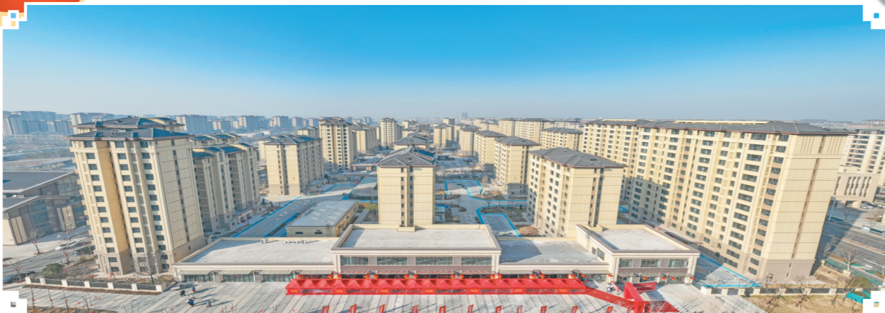
图为中铁二十局参建的河北雄安新区容西片区安置房二期项目。潘卫摄
