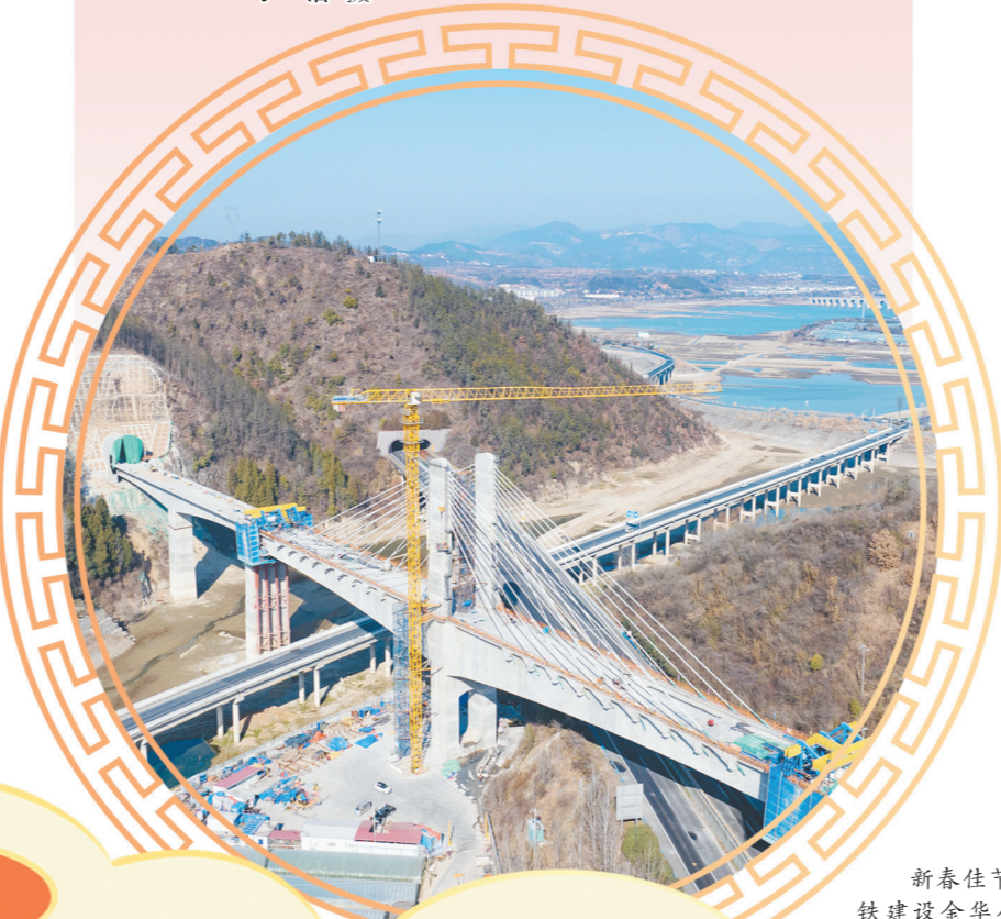
1月16日,临近春节,西十高铁湖北段建设现场依然是一片火热,随着中铁十一局一公司建设者将最后一方混凝土浇筑完成,标志着西十高铁柳家河福银立交大桥顺利合龙,工程建设取得阶段性胜利。 古建教 摄
