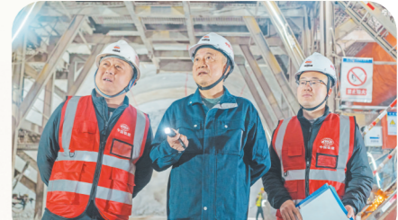
冯文波(中)带班作业，检查隧道初支喷射混凝土表面平整度。唐赋臻 摄
