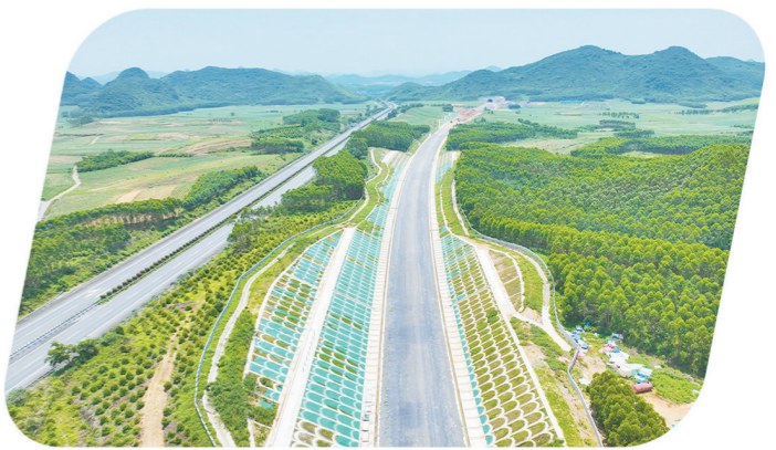
柳梧铁路1标路基段。张斌摄
