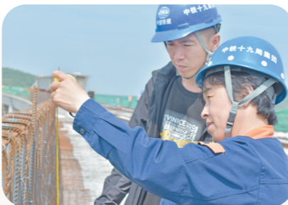
图为施蜀蓉在成自高铁测量防护墙预埋钢筋高度。
