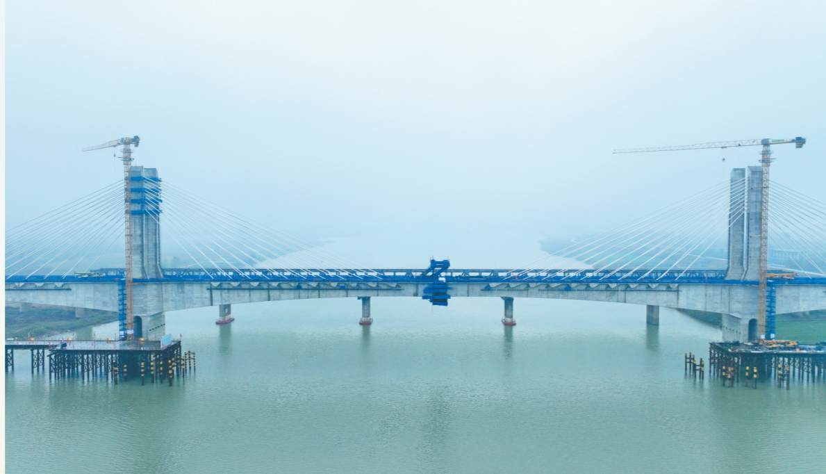
11月16日，上海院总体设计、中鉄十二局施工的淮宿蚌城际铁路淮河特大桥主跨顺利合龙。该桥主跨248米，是目前淮河已建成跨度最大的铁路桥。淮宿蚌城际铁路正线全长约161公里，设计时速350公里，设车站6座，建成运营后将作为皖北城市群连接合肥都市圈及沪宁杭等地区的便捷通道，对于打造“轨道上的长三角”，完善区域城际快速铁路网布局，促进区域经济协调发展等具有重要意义。图为合龙后的淮河特大桥主跨。 雷 昊 摄
