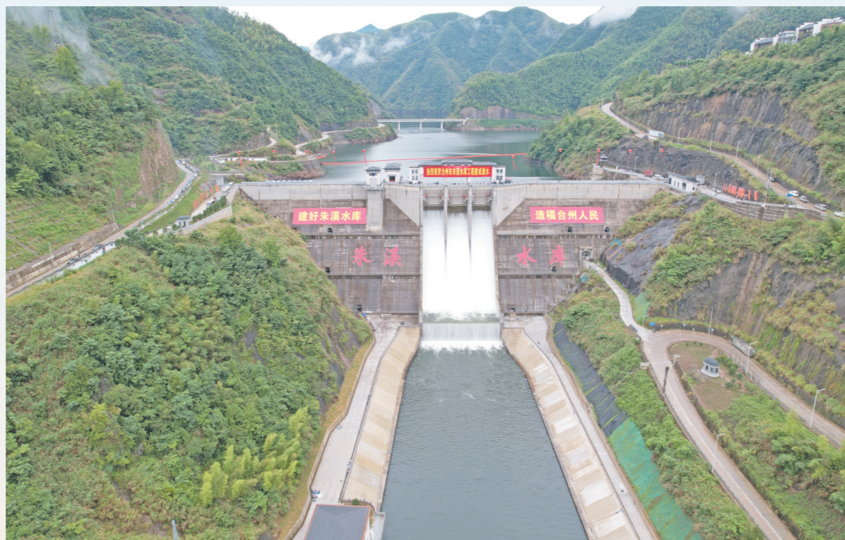
近日,由中铁十九局参建的台州市朱溪水库工程项目正式通水运行。该项目是国家172项重大水利项目之一,也是浙江省“五水共治”十大枢纽,台州市北水南调一期工程。建成通水后将有效解决台州南片350万人水资源短缺问题,也开启了台州市“北水南调”供水格局新篇章。图为水库通水运行现场。孙铭哲 摄
