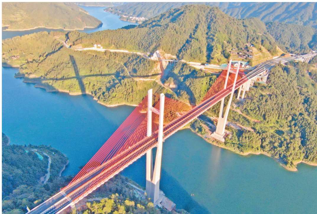
10月25日,由中国铁建投资建设运营的贵州剑河至黎平高速公路正式通车,贵州南北高速路网再添新通道。图为黔东南第一高桥——南孟溪特大桥。赵海林 摄
