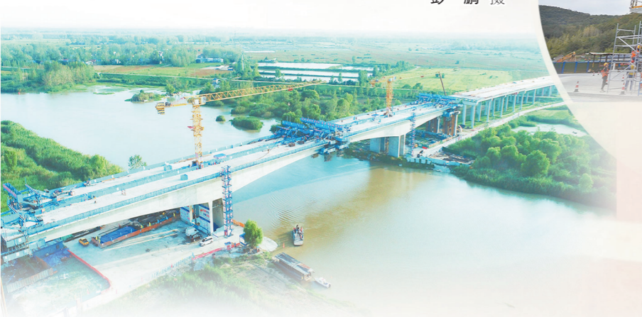
▼国庆期间,中铁二十三局五蒙高速项目全面掀起施工大干,确保10月底顺利完成浚河特大桥连续刚构右幅主线合龙。彭鹏 摄
