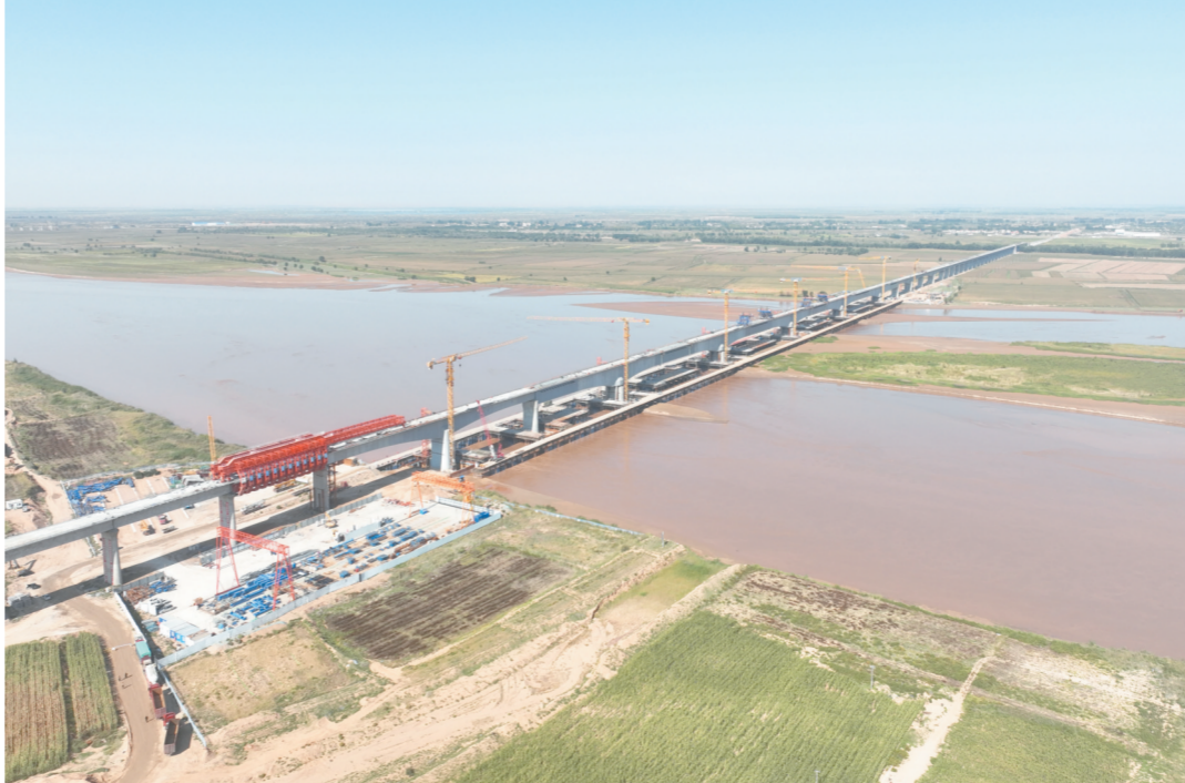
9月22日,随着最后一节重达575吨的钢箱梁成功吊装,由中铁十八局承建的头道黄河特大桥实现合龙贯通。磴口黄河特大桥全长5145.91米,跨越黄河主河道、包兰铁路、110国道和京藏高速公路。图为包银高铁磴口黄河特大桥合龙现场。赵一坚 摄
