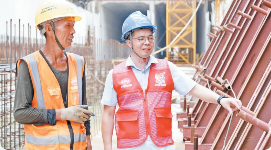
8月27日,在福建省厦门市大嶝岛上,中铁二十二局城际铁路R1线机场段土建预留二期项目工程师涂永清正在检查侧墙模板安装情况,指导班组长陈国喜改善施工工艺。该公司以创建“党员进班组”特色品牌为契机,挑选项目部业务能力突出的党员与班组长结对子,通过技术帮扶、安全教育、现场办公等方式,发挥党员先锋模范作用为施工生产赋能,受到广大工友们的欢迎。 许侨慰 摄
