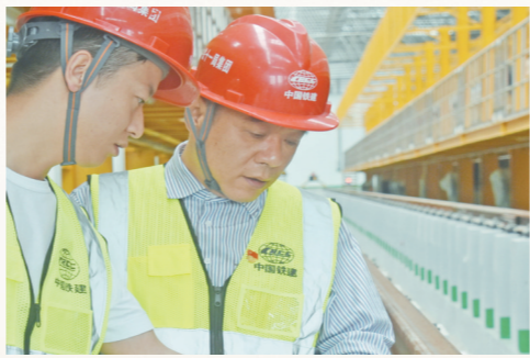
图为陆军书检查贵阳地铁S1线皂角坝车辆段施工现场。王嘉摄
