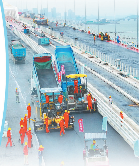
澳门大桥南引桥桥面沥青铺装。 陈振辉 摄
