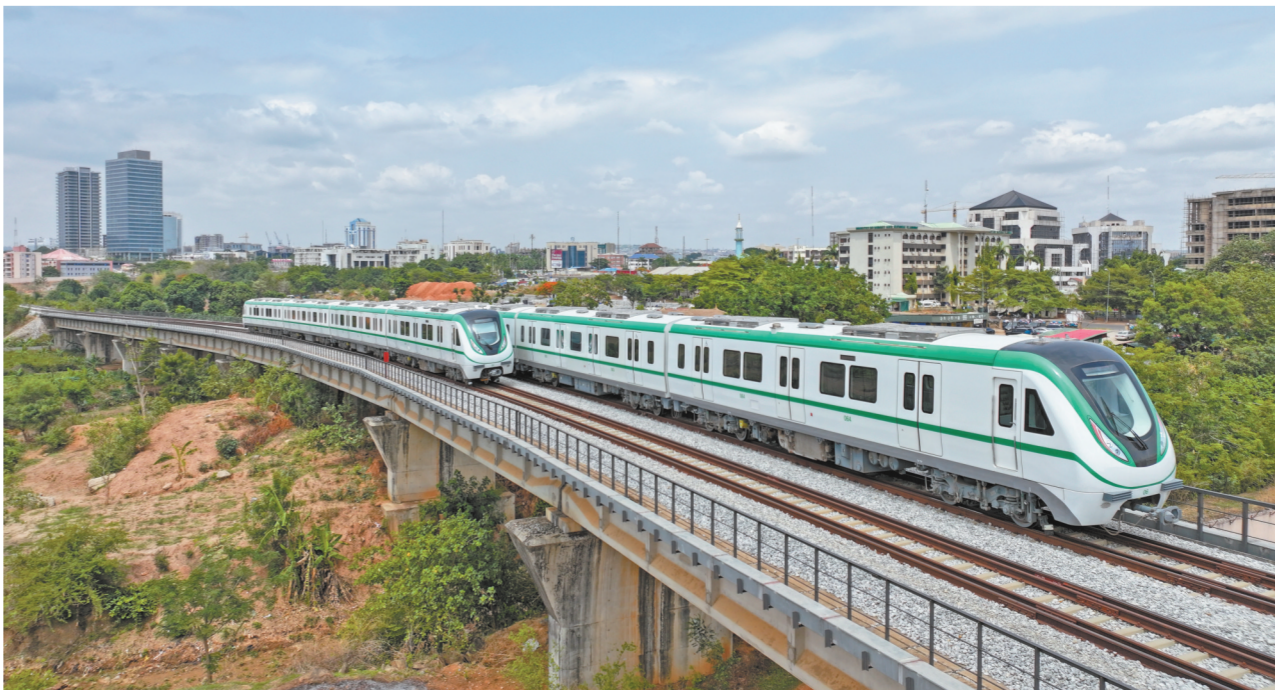
当地时间5月29日,由中国土木承建的尼日利亚首都第一条城市轨道交通线路——阿布贾城铁一期正式投入商业运营。该项目主要连接阿布贾市中心、首都国际机场、国铁阿卡线以及库巴卫星城,总长约45公里,采用中国铁路技术标准——双线标准轨,列车最高运行时速100公里。开通商业运营后,将极大缓解阿布贾的交通压力,节省市郊间的通勤成本,带动当地经济社会发展。闫玉娟 摄
