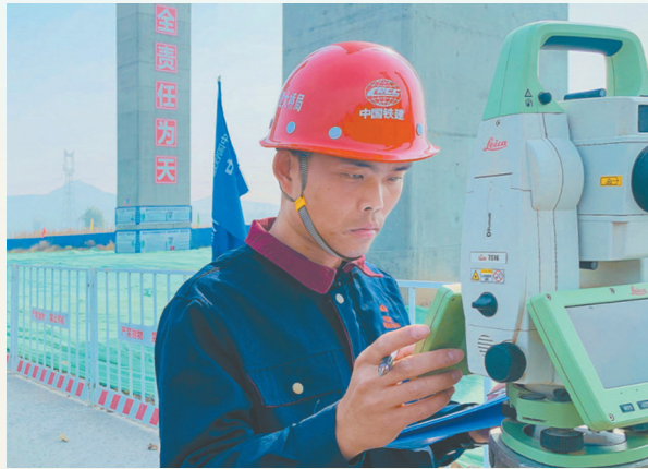
王金玉在黎霍高速公路项目现场进行桥梁结构测量作业。 刘韩斌 摄
