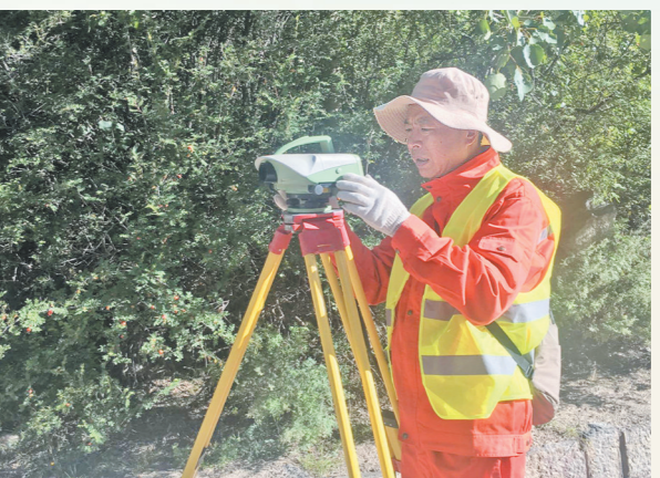
张斌在南昆铁路既有线改造项目开展测量工作。 吕君 摄
