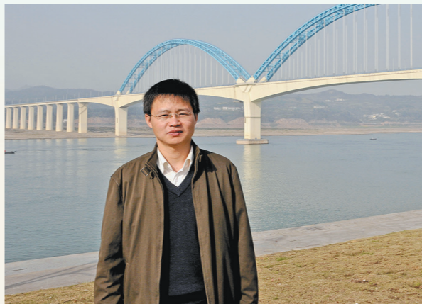
严爱国在宜昌长江大桥现场。 铁四院 供图
