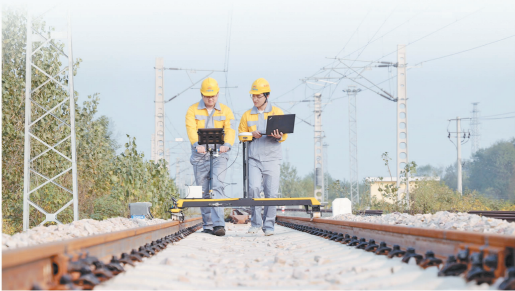
运用轨道小车开展轨道精调。
