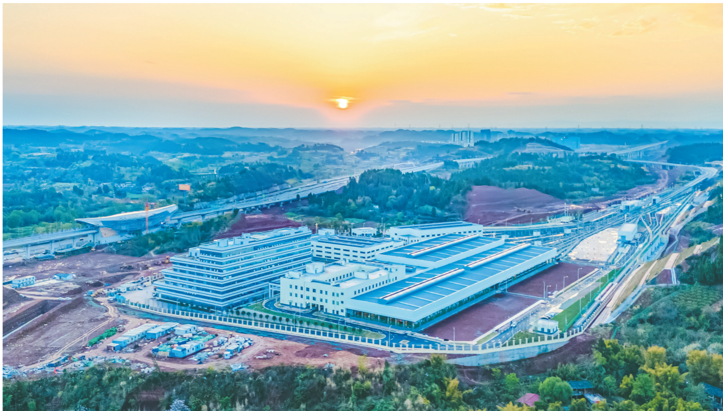
3月31日,由中铁十四局承建的成都轨道交通阳线空车车辆段投入使用,这是国内首个采用梯田造型设计的地铁车辆段。整个车辆段依山而建,中心枢纽的综合楼采用错层梯田式设计,成为具有独特美感的小“布达拉宫”。图为梯田造型地铁车辆段航拍。范成涛 摄
