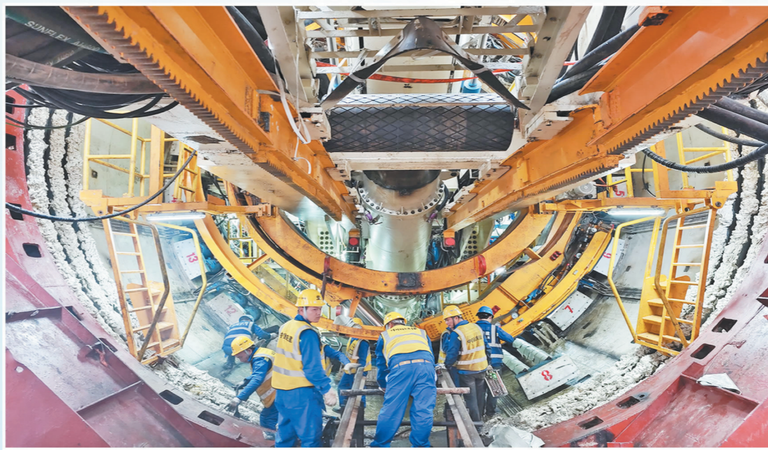
3月1日,铁建南方深大城际1标龙民区间技术人员和工人正紧锣密鼓地对盾构机进行始发前的最后调试和检查,为后续盾构机安全、平稳运行保驾护航。 杨国辉 摄
