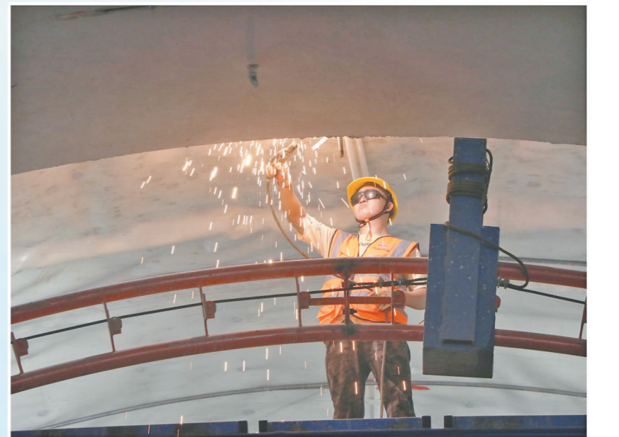
3月13日,在中铁十一局承建的西渝高铁康渝段站前十五标一级高风险隧道和重难点工程——四方山隧道出口,建设者正在焊接钢筋,全力保障施工进度。 胡林 摄
