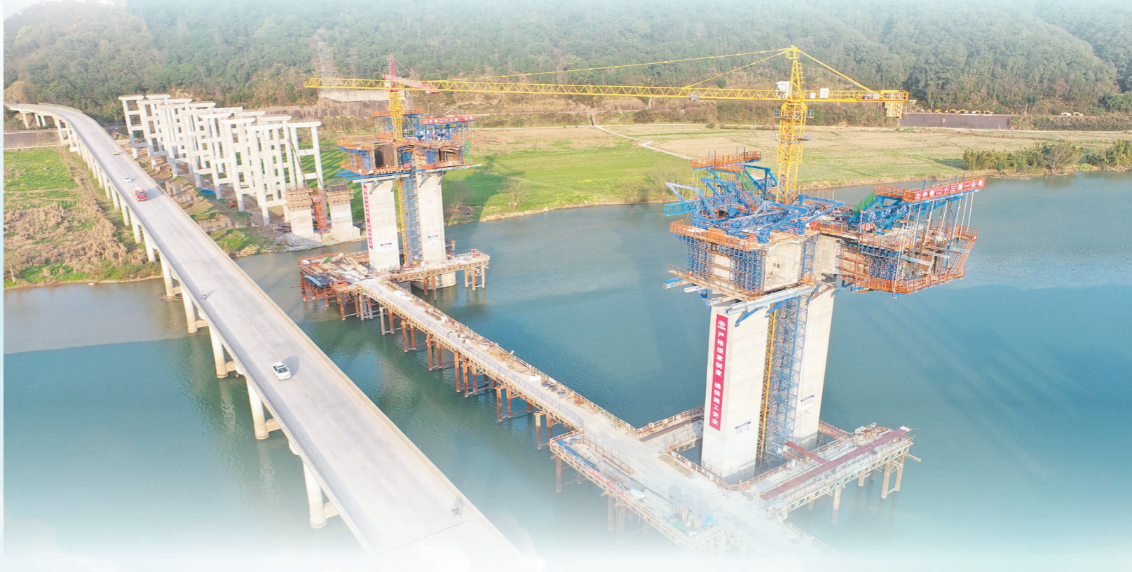
3月13日,在祖国的东海上,中国铁建港航局承建的世界最大跨度单跨吊箱梁悬索桥——双屿门大桥正紧锣密鼓地进行佛渡侧索塔承台钢筋绑扎施工。 黄子钊 摄
