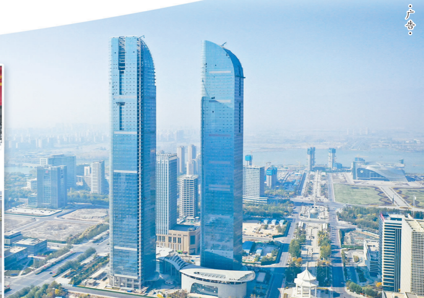
中铁城建承建的高301米的银川绿地中心双子塔楼,获中国钢结构金奖
