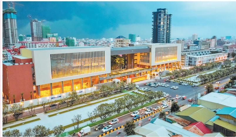
中铁城建承建的柬埔寨国防部办公大楼
