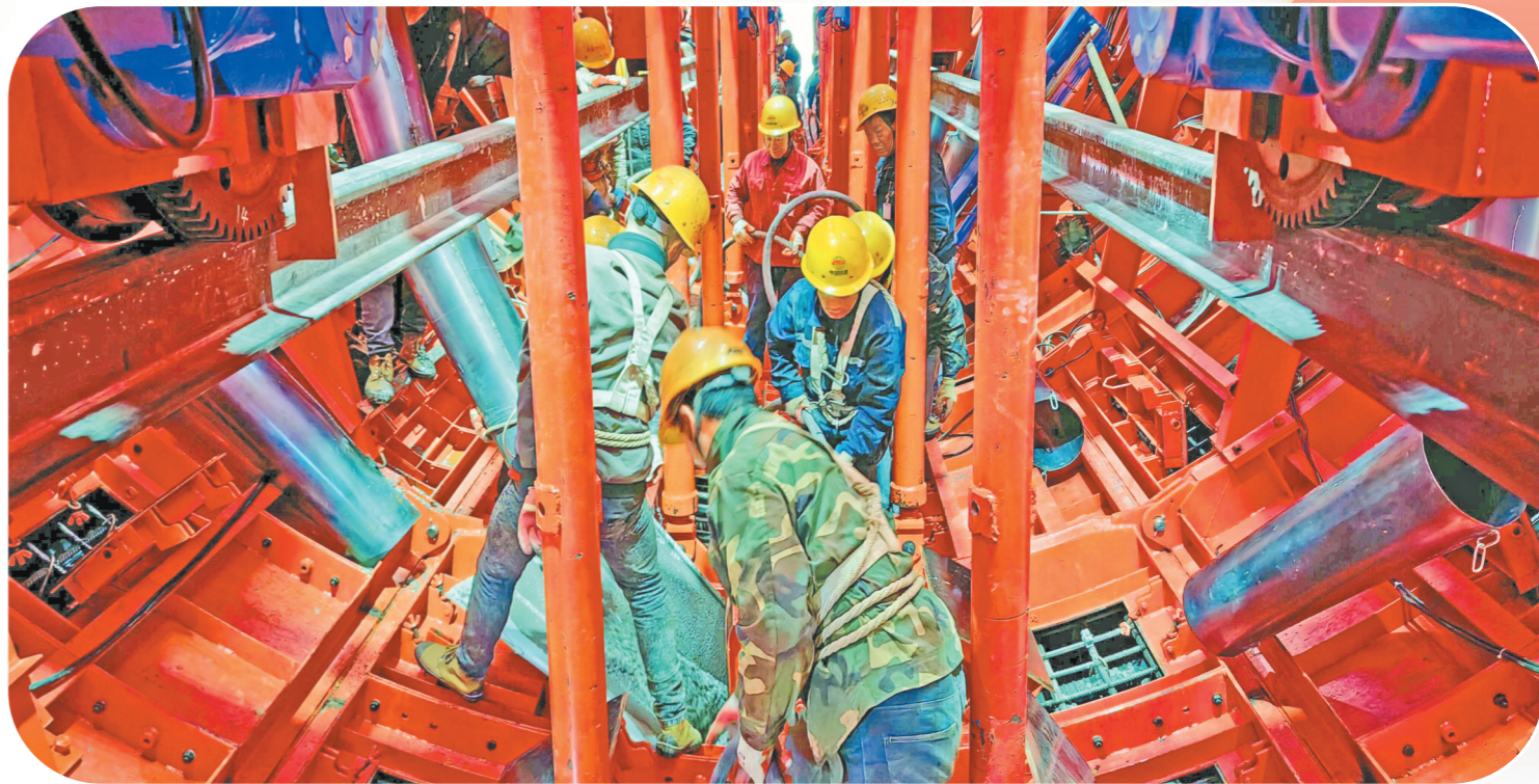
近日,在中铁十八局二公司亭子口灌区一期项目施工现场,工人正在中国铁建最大的一体化自行式造槽机内进行槽身混凝土浇筑。丁迪摄
