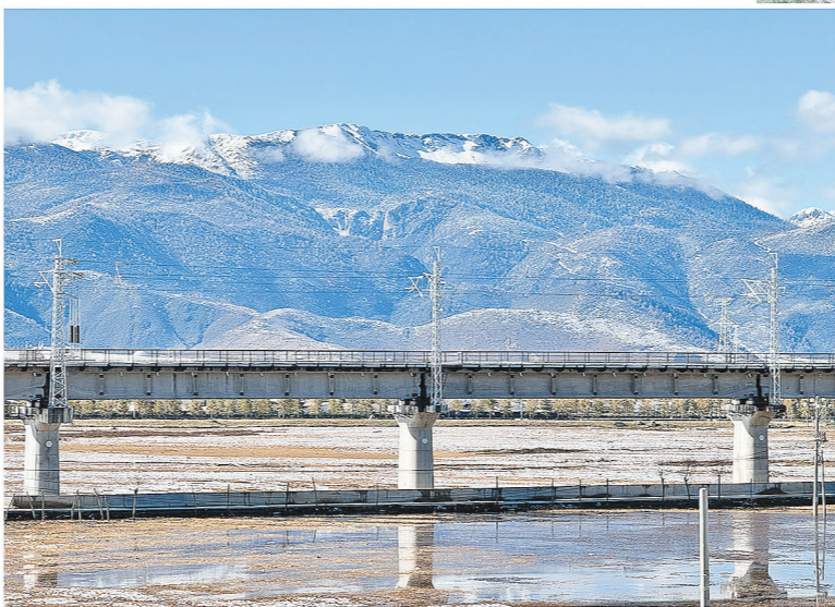
▲2023年11月26日,中铁十六局、中铁二十一局、中铁建电气化局、中铁城建参建的丽香铁路正式开通运营,丽香铁路被誉为“美丽云岭天路”。图为丽香铁路神鹰路特大桥。 于游 摄
