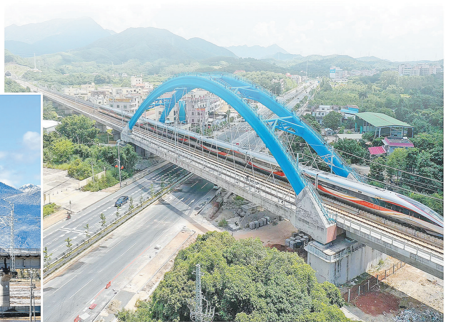
▲2023年9月26日,由铁四院设计,中铁十一局、中铁十二局、中铁十七局、中铁建电气化局参建的广汕高铁正式开通运营。广汕高铁是“轨道上的大湾区”高铁骨干网的重要组成部分。图为广汕高铁背子头特大桥。 刘皓 摄
