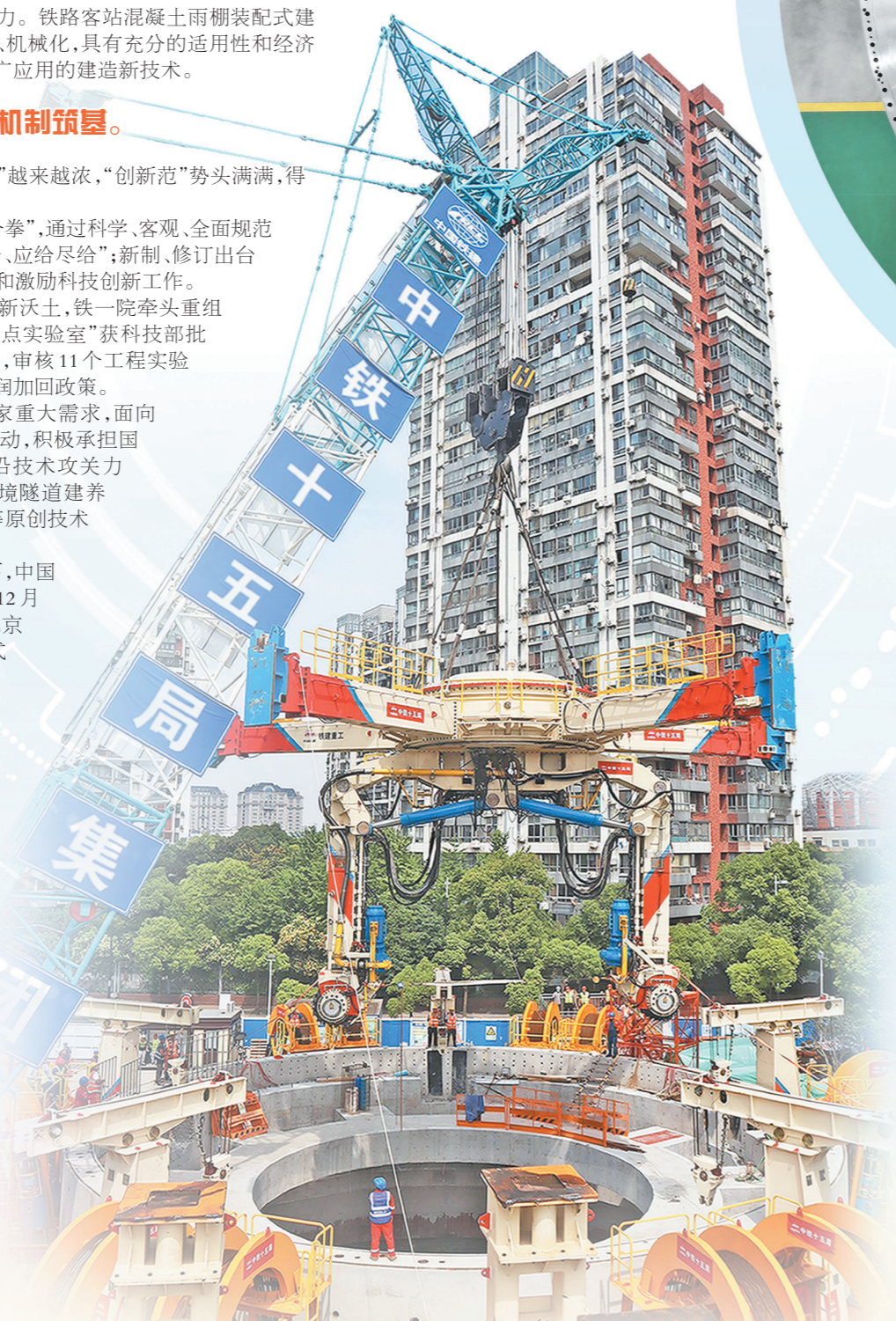
铁建重工和中铁十五局联合研制的全球最大竖井掘进机“梦想号”，在上海市静安区地下智慧车库项目应用，单个竖井开挖直径达23.02米，是目前世界最大直径竖井。肖飞摄
