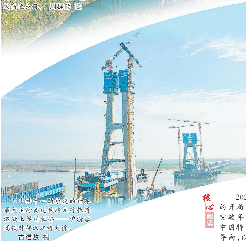
中国铁建参建的国内同期规模最大、投资最大的高速公路项目——渝湘复线高速公路。周群能 摄
