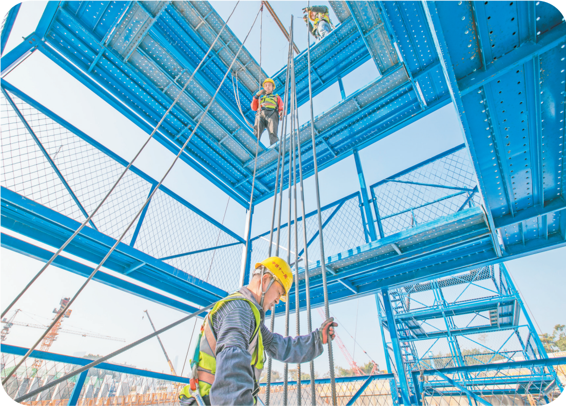
1月16日，在穗莞深城际铁路前皇段中心公园停车场建设工地，中铁十一局建设者利用晴好天气抓紧施工。穗莞深城际铁路前海至皇岗口岸段全长21.158公里，由中铁十一局承建的穗莞深城际铁路前皇段中心公园停车场总建筑面积约5.4万平方米，目前建设进度已过半。穗莞深城际铁路前皇段建成后，对完善粤港澳大湾区城际轨道骨干网络具有重要意义。图为建设者在进行钢筋安装施工。 古建敦 摄
