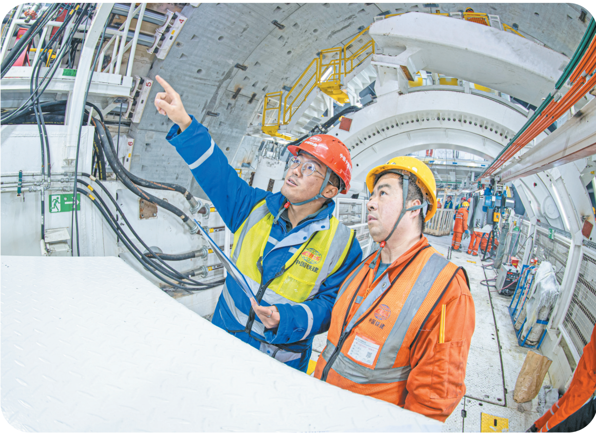
1月17日，随着青岛胶州湾二隧南线主线隧道20环拼装完成，“海天号”盾构机正式开启穿海之旅。该隧道为目前世界上建设规模最大、长度最长的海底道路隧道。图为中铁十四局盾构机维保人员对设备进行日常巡检。 丁 翔 摄
