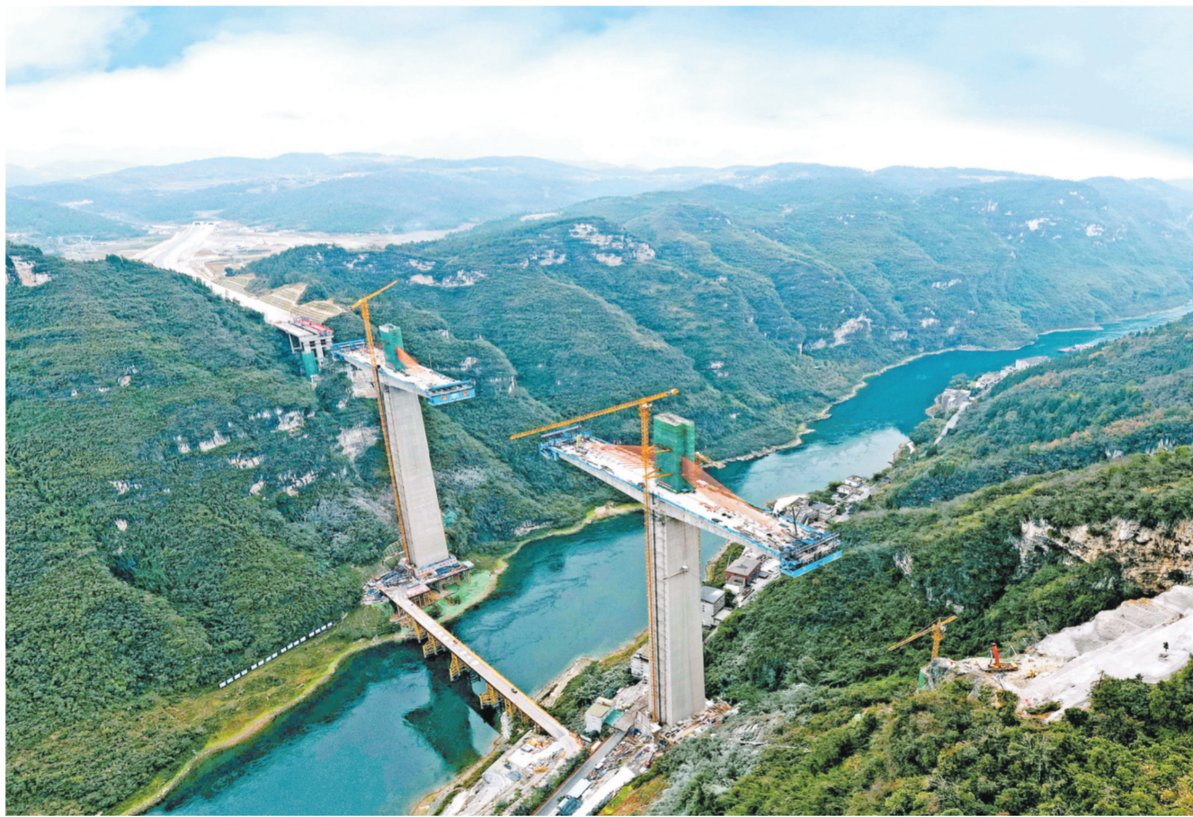
1月3日,由中国铁建昆仑投资集团参与投资、铁一院勘察设计、中国铁建港航局参建的亚洲第一高墩矮塔斜拉桥——重庆渝湘复线高速公路(彭水至酉阳段)磨寨乌江特大桥顺利完成索塔封顶。大桥3号主墩高216米,是亚洲同类型桥梁中的最高墩。此次完工的索塔采用矩形钢筋混凝土塔,桥塔顶部距离水面320米,相当于106层楼高。图为完成索塔封顶的磨寨乌江特大桥。 刁攀摄
