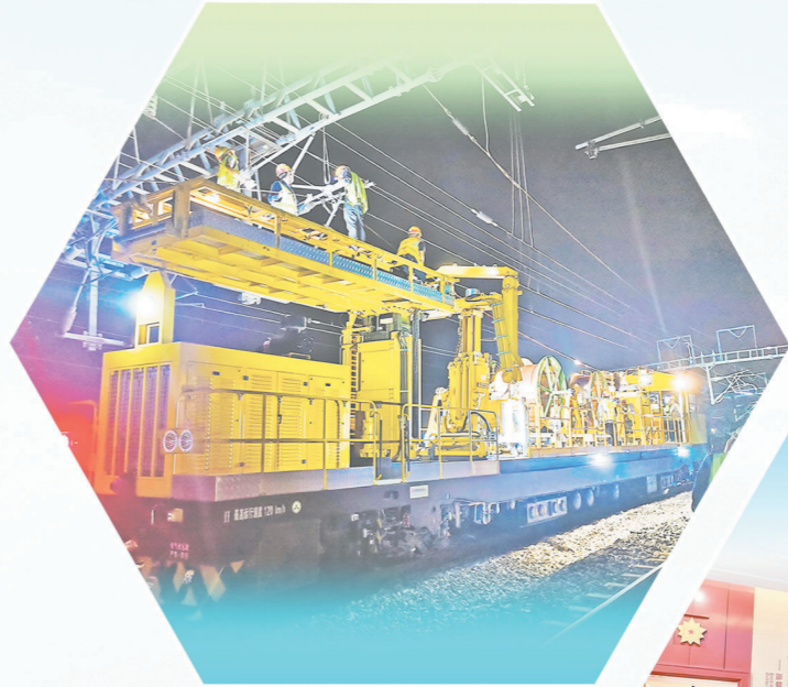
贵广铁路提质改造“四电”工程项目接触网轨道车施工
